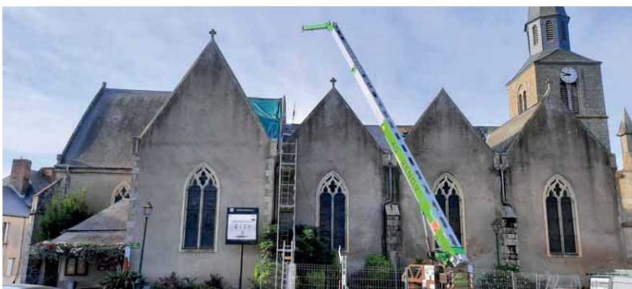
Intervention sur l'église par AG Rénov.
